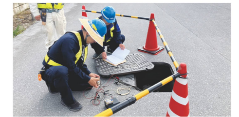
▲電位測定作業の様子
